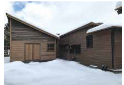
旧武井商店酒造部を裏手から見た工事前(上)と完了直後(下)
