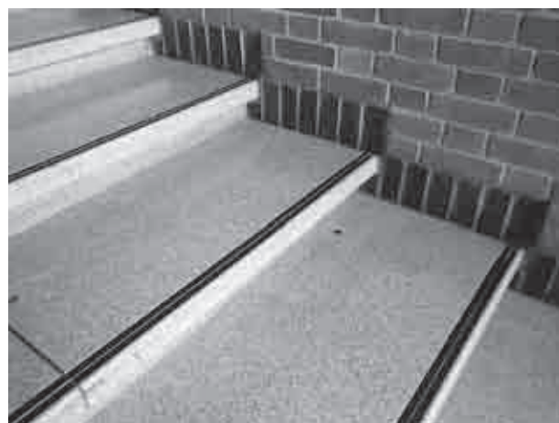
改修後の階段(段鼻)
