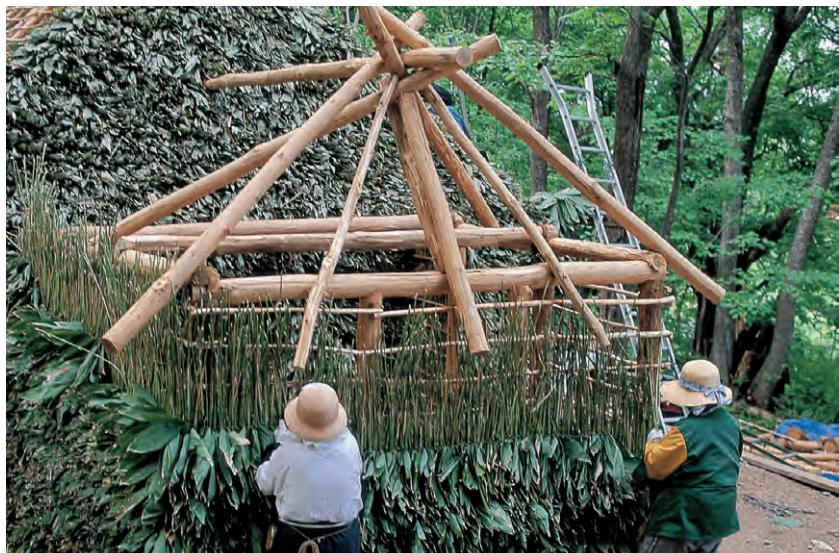
写真15 ササで壁を葺いているようす
