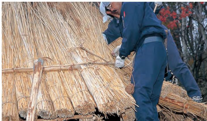
写真13 カヤで屋根を葺いているようす
