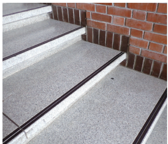
写真3 階段の段鼻（へり）にシートを貼った様子
