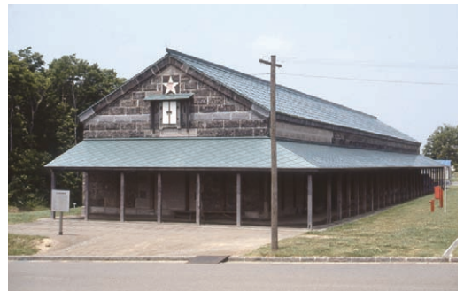
旧札幌拓殖倉庫
