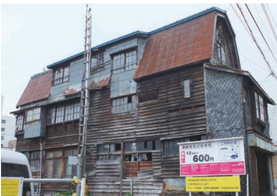
小樽に現存する（5月11日現在）天然スレートのうろこ壁のこる木造3階建の住まい 最新の民家調査速報？小林が知る限り小樽で唯一のうろこ壁の現存例です。
