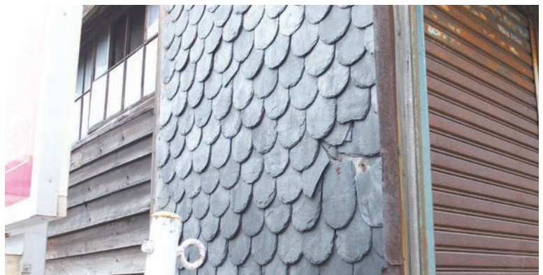
小樽に現存する（5月11日現在）天然スレートのうろこ壁のこる木造3階建の住まい 最新の民家調査速報？小林が知る限り小樽で唯一のうろこ壁の現存例です。
