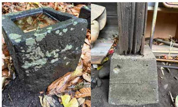
図5 手水鉢への地衣類の付着（左）と木材の腐朽と思われる痕跡（右）（2022年11月30日撮影）
