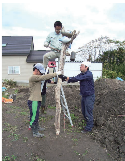
(3) 脚立の両側から2人で柱を垂直に支える
