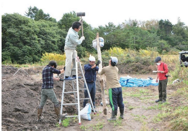
(4) 又木部分を土嚢で覆い掛矢で打ち込み
