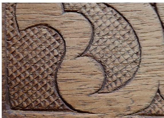
2 表面の摩耗の状況①
