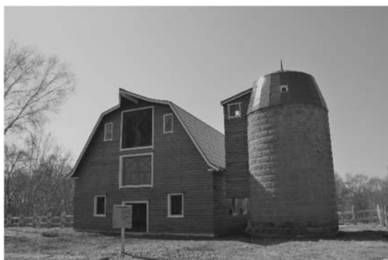
旧小川家酪農畜舎 補修後の様子
