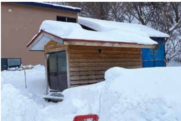
写真9 積丹町来岸「カワシモサマ」の祠全景
