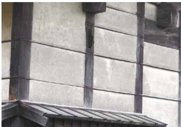
写真14 旧岩間家農家住宅の外壁 ※復原時に土壁の真壁を抑えるように横棧を設置している
