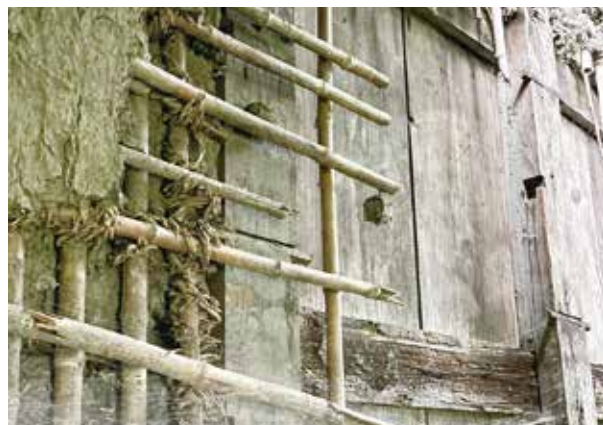
写真15 亶理町で確認した横棧つきの土壁の大壁 ※横棧は柱から50mm程度しか出ている様子が分かる
