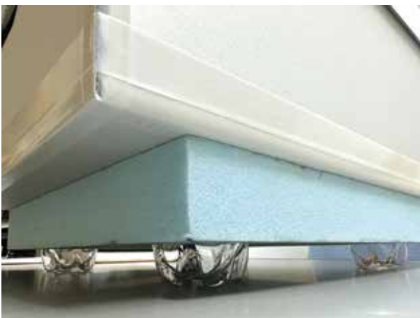
図25 耐圧ペットボトルと押出発泡ポリスチレンを組み合わせた嵩上げ方法
